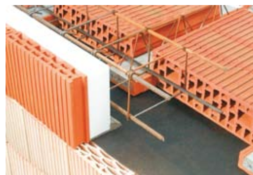
Uložení stropní konstrukce s izolantem na nosném obvodovém zdivu
